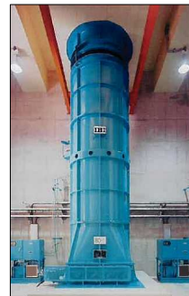
菅生TN 送風・排風機 外回り：送風2台+排風2台 内回り：送風2台+排風2台
